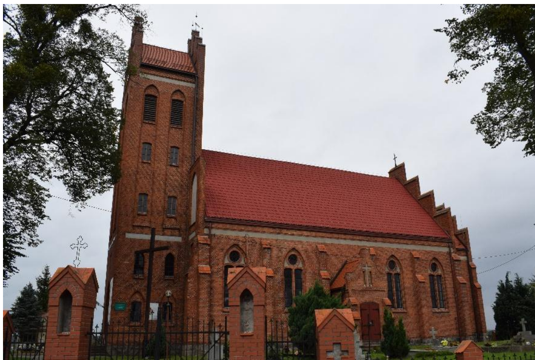
Fot. 8. Kościół w Płochocinie, wrzesień 2025 r.
